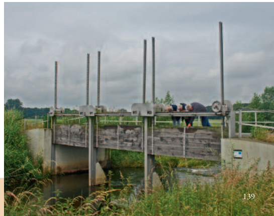
Stauwehr an der Vechte
