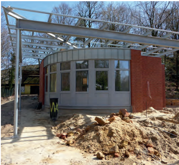
Baumaßnahmen im Eingangsbereich der Freilichtbühne
